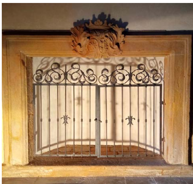
1. Pískovcový krb, konírna, Zámek Troja, stav po restaurování
