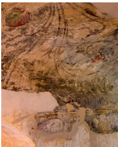
2. Detail pozdně-gotických fragmentů malířské výzdoby stropu klenby spojovací chodby / prampouchu, v 1. patře Domu U Kamenného zvonu, detail, stav po restaurování
