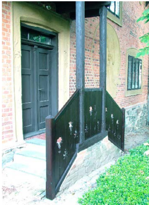
2. Stav po restaurování
